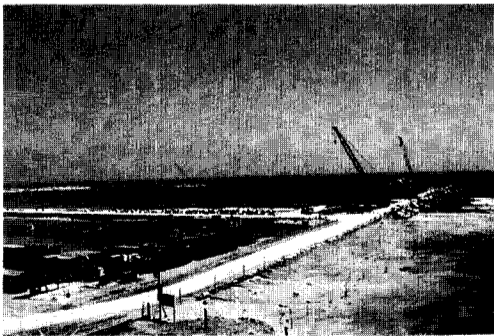
←湾岸工事現場
